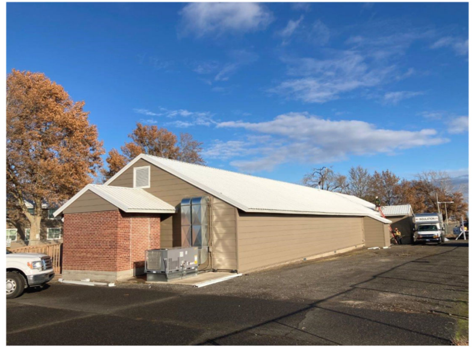
Umatilla STARBASE remodel
